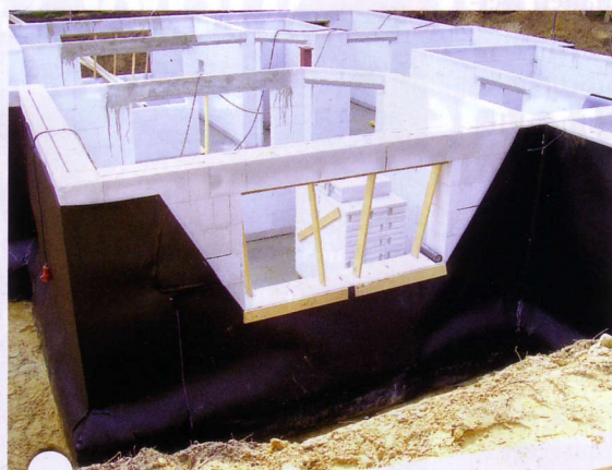
Die Dichtungsbahn wird an den Kellerwänden hochgezogen (links). Die Nähte werden verschweißt und mit einer Vakuum-Glocke (rechts) auf ihre Dichtheit geprüft
