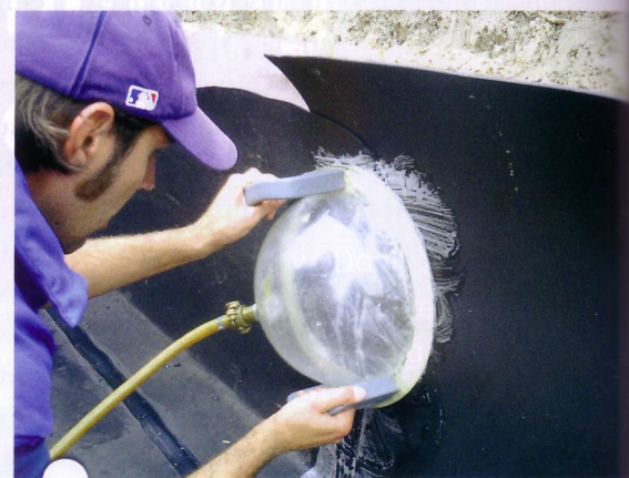
Die Dichtungsbahn wird an den Kellerwänden hochgezogen (links). Die Nähte werden verschweißt und mit einer Vakuum-Glocke (rechts) auf ihre Dichtheit geprüft
